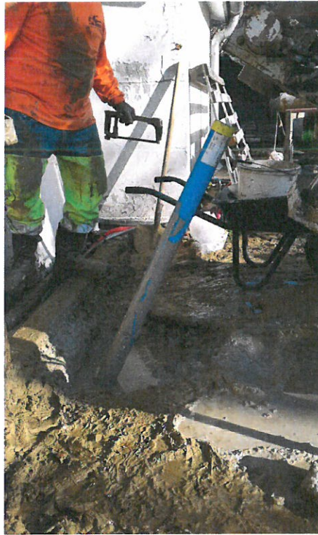
Réalisation du puits (PS8) incliné à 25°C
