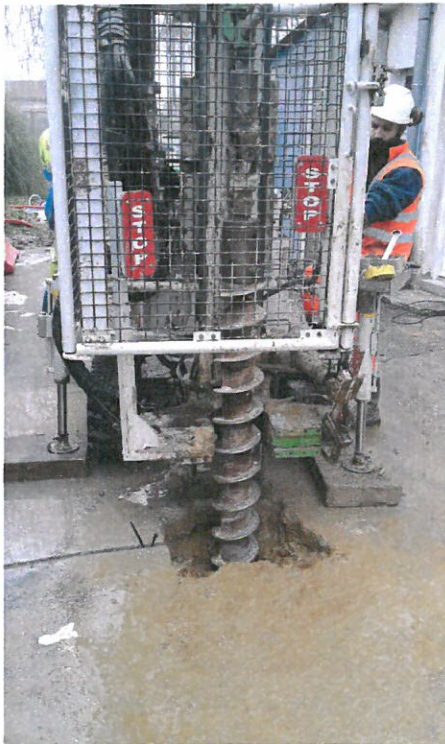
Forage à la tarière creuse
